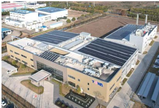
南通工場の太陽光パネル
