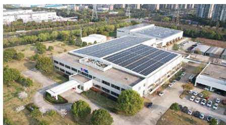
蘇州工場の太陽光パネル
